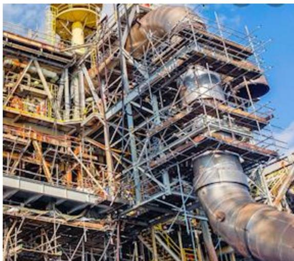
图32 扣件式管道脚手架
