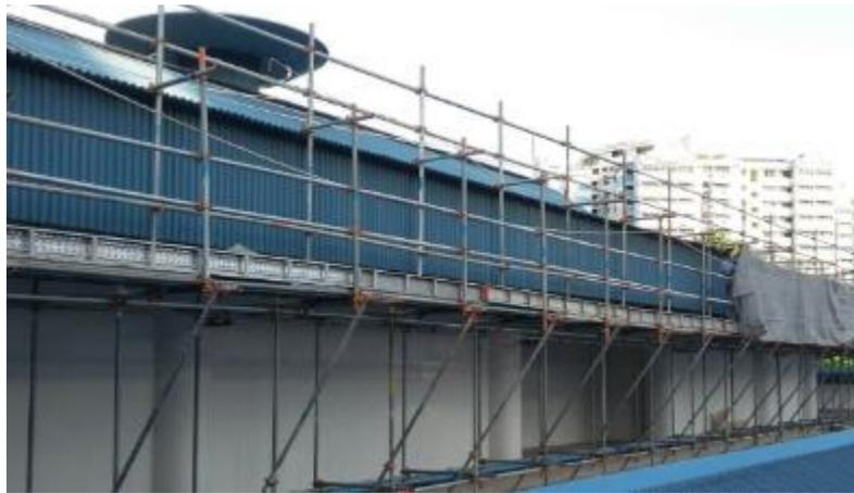
图31 悬臂式脚手架
