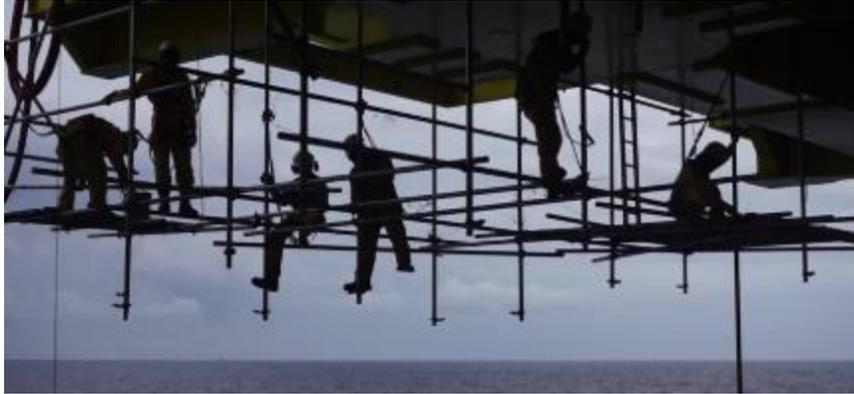
图30 悬挂式脚手架
